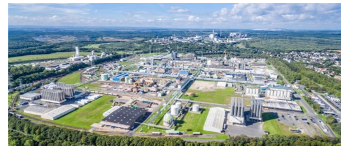
2009–2012: Chemergy: Errichtung einer Wasserstofftankstelle beim Chemiepark Knapack in Hürth-Knapack, Bundesförderung
