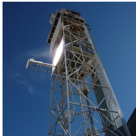
**2004–2008: „HYDROSOL II“ (EU):** kontinuierliche H<sub>2</sub>-Produktion mit zwei 100-kW-Reaktoren auf der Plataforma Solar de Almería (PSA) des CIEMAT
